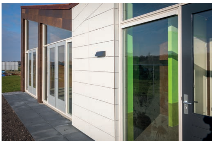
Op de gevel van het Field Lab is biocomposiet toegepast met verschillende coatings.
